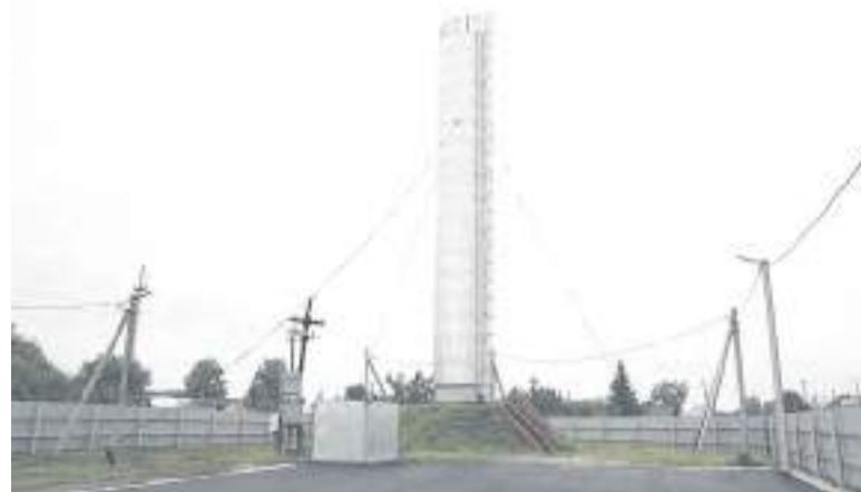
В Алтайском крае проводится модернизация объектов водоснабжения.
