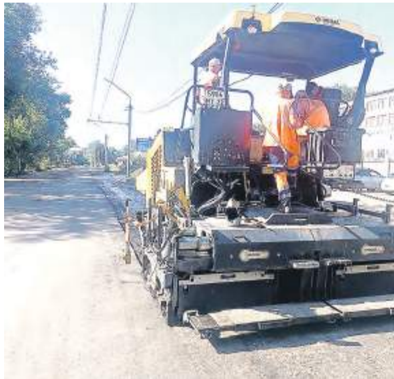
Идет ремонт дороги на пр. Ленина в г. Рубцовске.
