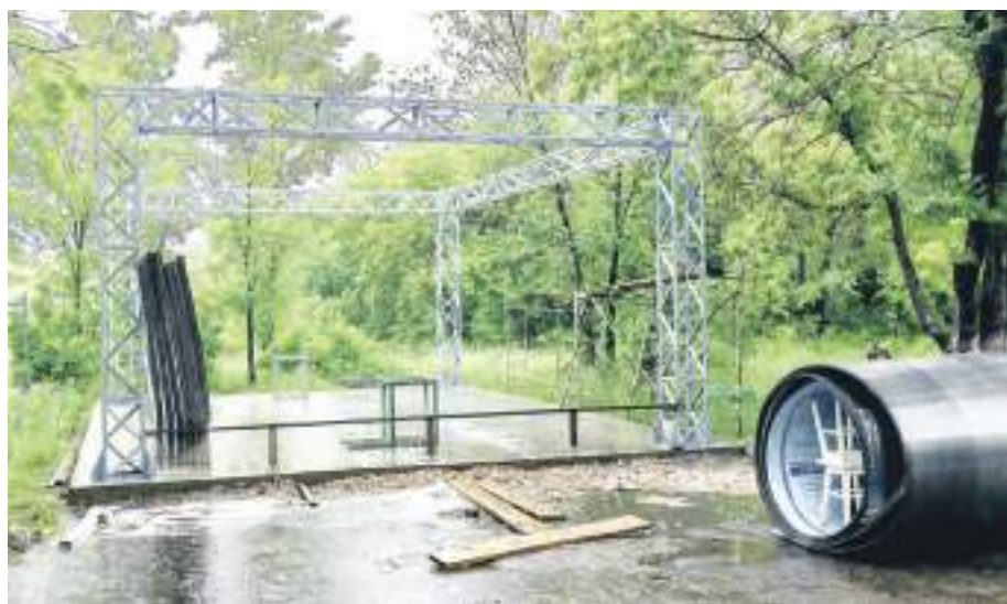
У ДК «Строитель» идет монтаж сцены.
