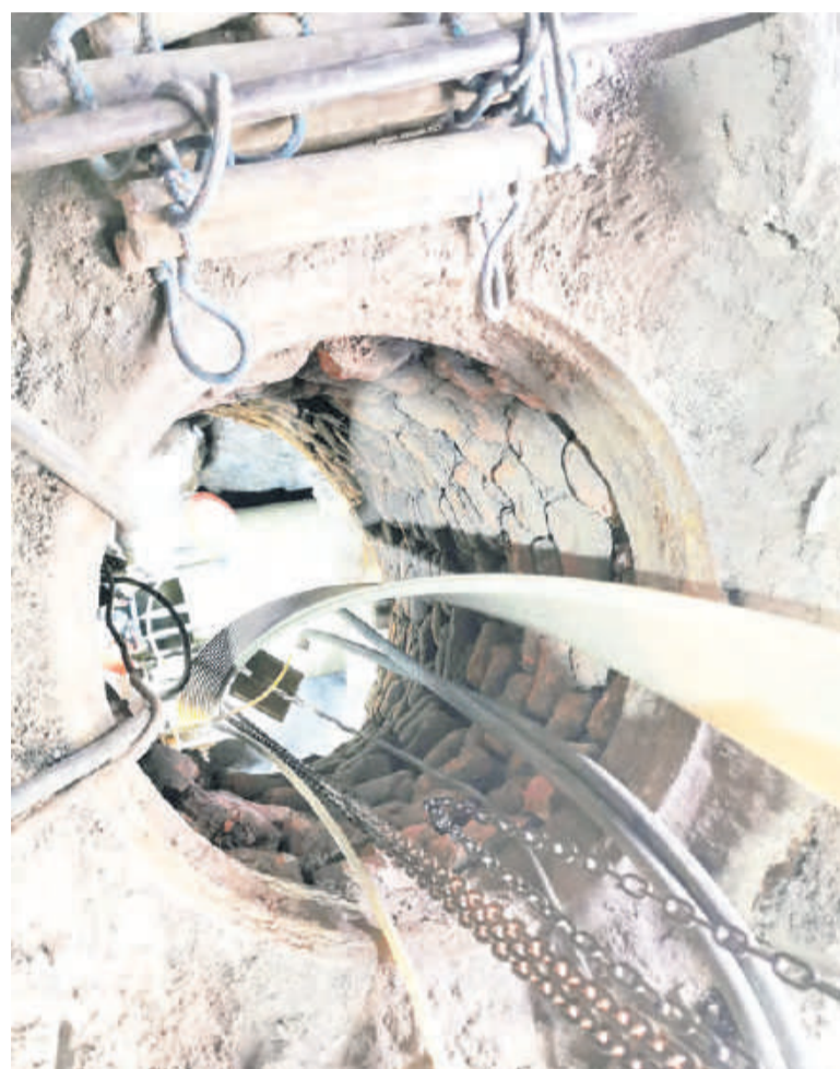
Процесс санации коллектора спирально-навивной технологией.
