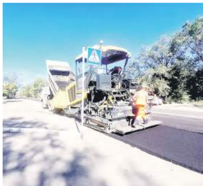
Идёт асфальтирование ул. Тракторной.
