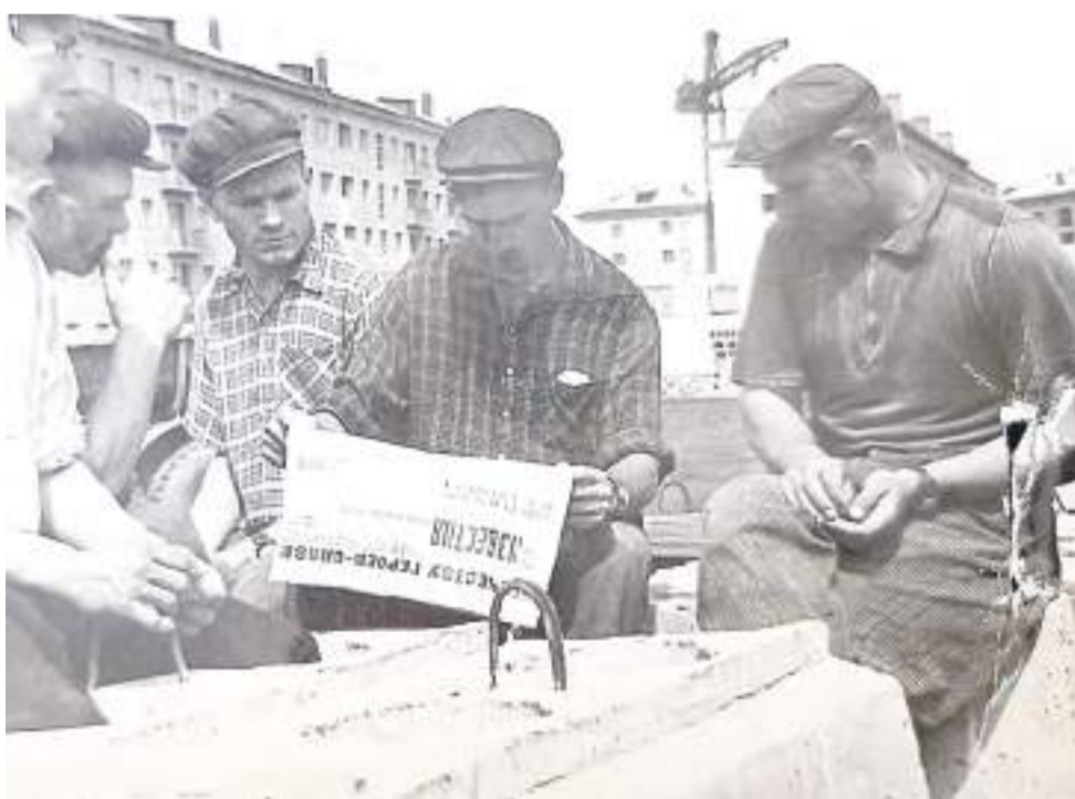
Бригада строителей во время обеденного перерыва.
