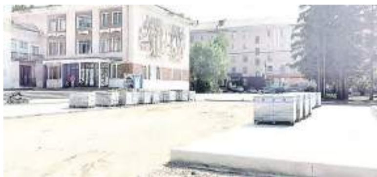
Здесь еще предстоит уложить тротуарную плитку.
