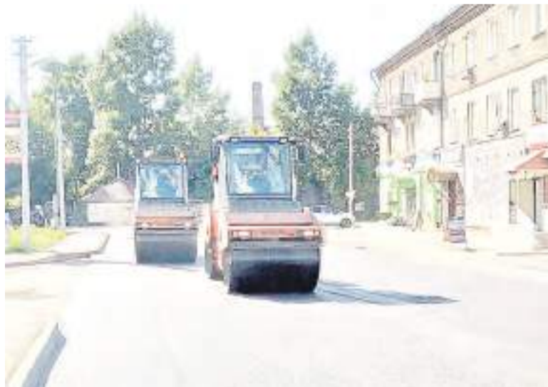
Идет укладка второго слоя на переулке Гражданском.
