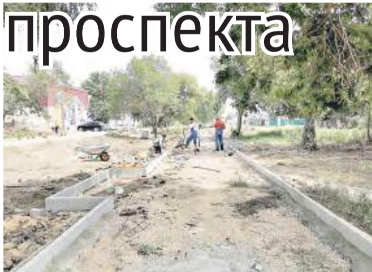
Работы на пр. Рубцовском планируют завершить к 1 сентября.
