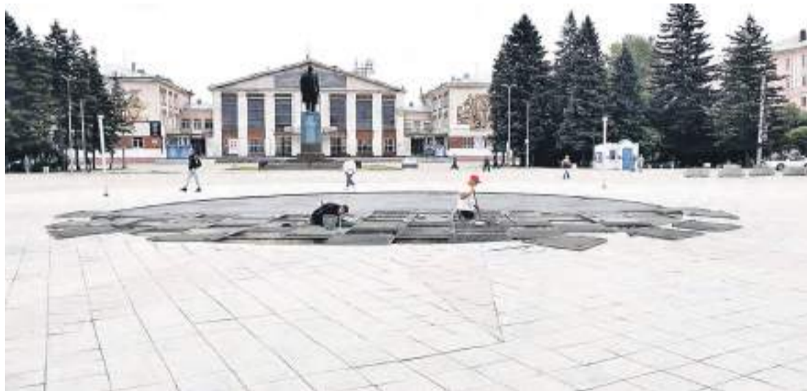
Идут работы по подготовке фонтана к запуску.
