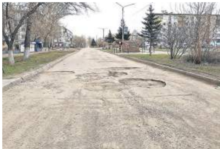
Первоочередной ремонт дороги будет на бульваре Победы.
