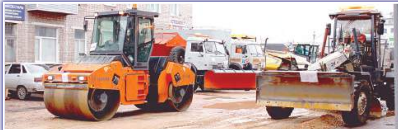
Идёт выравнивание проезжей части.
